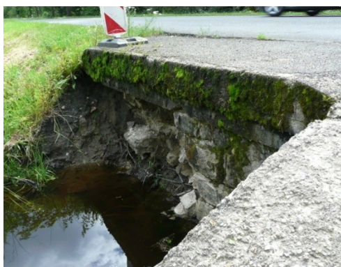
Obr. 7 Propustek č. 1 ústí na pravé straně ve směru Přimda – Rozvadov zneprůchodněný bobří hrází
